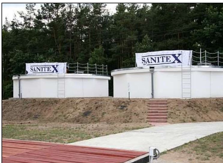
Zdjęcie 7. Stacja uzdatniania wody w Rzepinie
